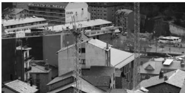
Grues en una construcció a Andorra la Vella.
